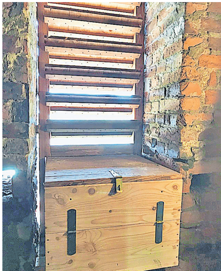
Bei der Anbringung der Schutzluken in den Turmfenstern wurde auch an einen Platz für bedrohte Tierarten gedacht
