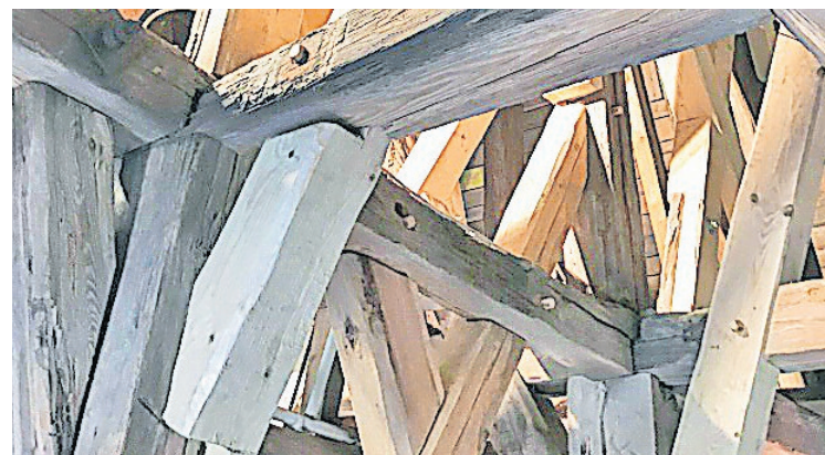
Ende des Jahres konnte der Dachstuhl gründlich saniert werden. In liebevoller Zusammenarbeit wurden Schwergewichte an Holz verbaut und hunderte Nägel eingebracht. Fotos: Axel Geldmeyer
