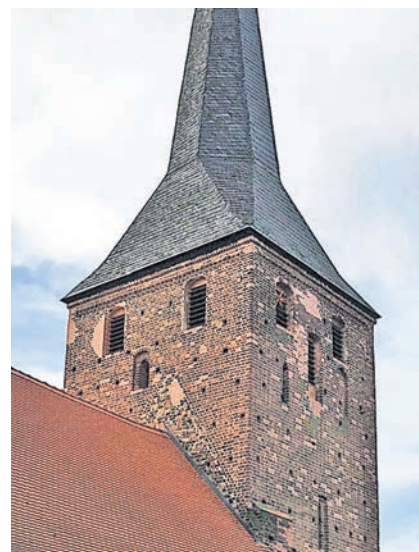
Der Krieschower Kirchturm wird derzeit aufwendig saniert
