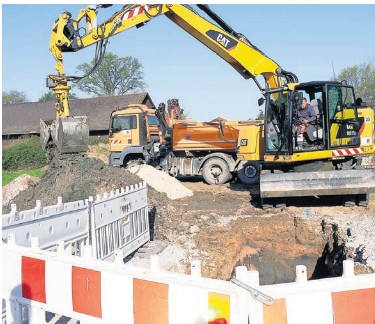
Bevor die Trinkwasserleitung verlegt werden kann, mussten große Erdmassen bewegt werden.
