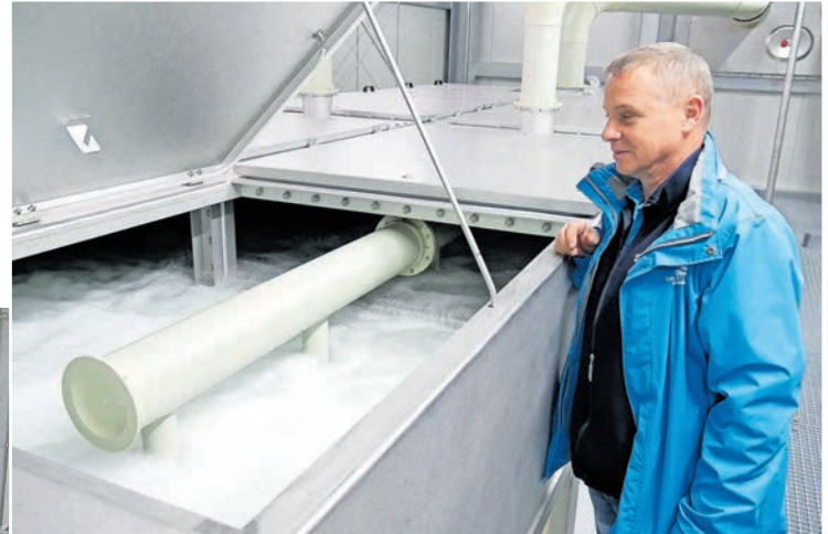
Bild oben: Bernd Scheppan, Gruppenleiter Wasserwerke der LWG, kontrolliert an einem geöffneten Flachbelüfter das Luftblasenbild.
