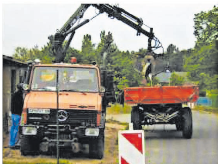
Bild 3: Mitarbeiter des Bauhofes führten die Abrissarbeiten aus
