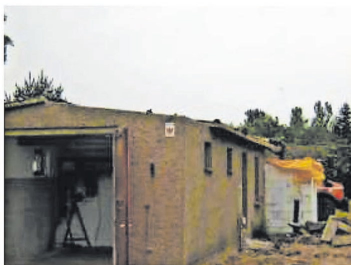
Bild 2: Abriss des Gebäudes 2007
